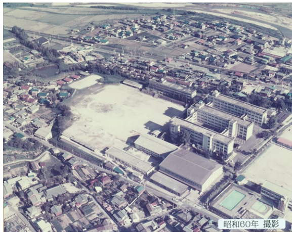
2-34 校舎航空写真（北から）
