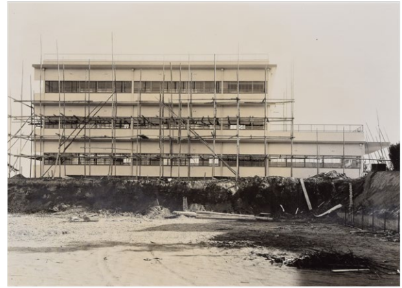
2-22 建設中第四棟
