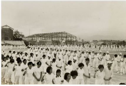
2-16 建設中体育館 昭和36年(1961) 伊藤真次家
