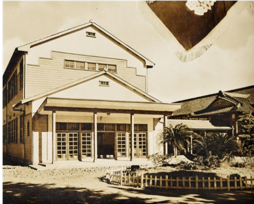
2-8 玄関つき木造二階建て校舎(旧第二校舎) (卒業アルバム1953)
