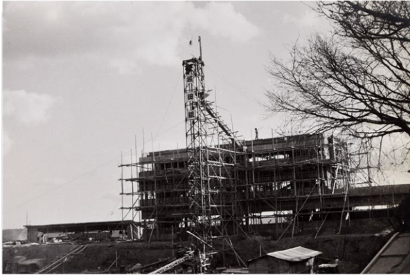
2-21 建設中第四棟
