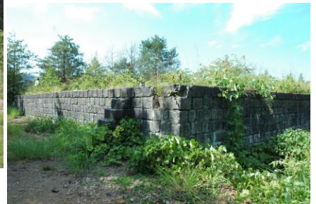
沈殿池跡の現況
