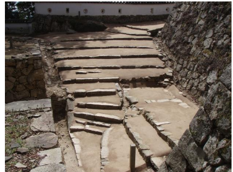
備中松山城跡（国史跡） 平成 21 年度保存整備を実施した石段
