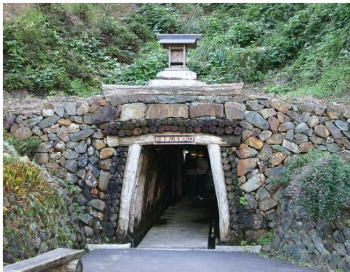
笹畝坑道入口
