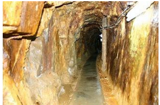
笹畝坑道の内部
