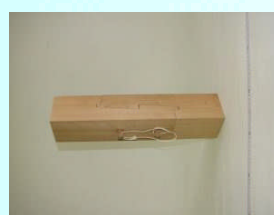
追っかけ大栓継（おっかけだいせんつぎ） 横に使う材木に用いる 追っかけ大栓は、柱にも用いる
